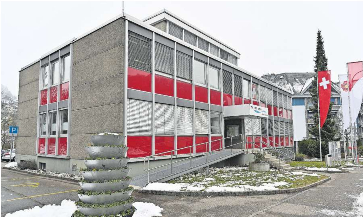
Das Gemeindehaus aus dem Jahr 1967 ist sanierungsbedürftig. Daher wollte es der Gemeinderat verkaufen.
